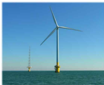
洋上風力発電設備 (イメージ)
